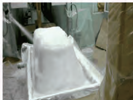
无溶剂涂料施工
